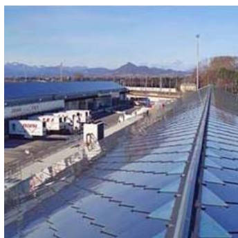
Saint-Charles International, © Solaire France
