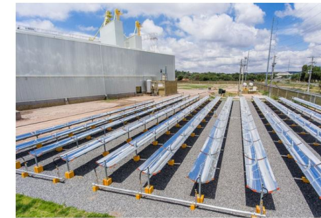
Der Bericht Solar Heat Worldwide zeigt, dass es in Mexiko die meisten SHP-Anlagen gibt. Hier sind Parabolinnenkollektoren bei Comercial Ferrajera de Lagos (COMFOSA) zu sehen (Bildquelle: COMFOSA)
